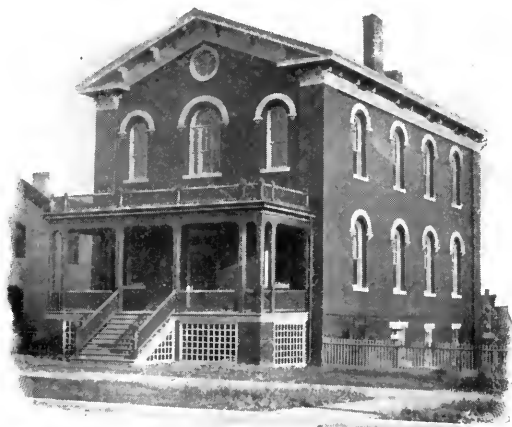
Die erste Hochschule. (First High School Building.)
